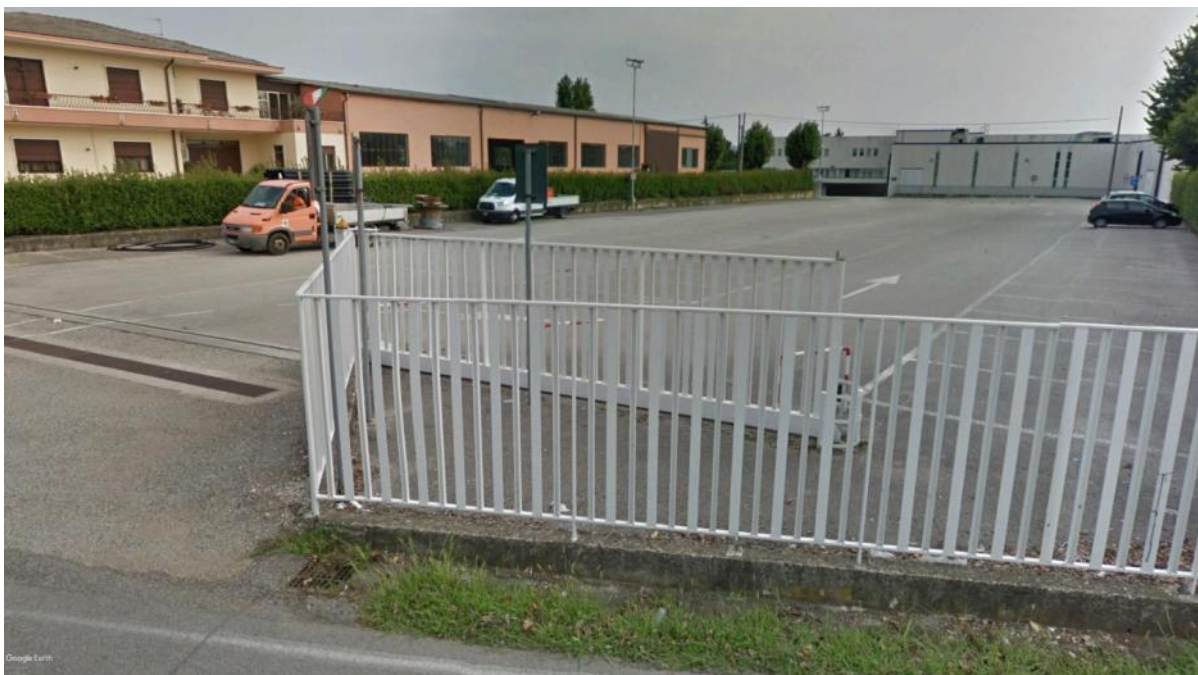
Foto 6: ingresso e piazzale laterale al negozio Ramonda da via Bruschi
