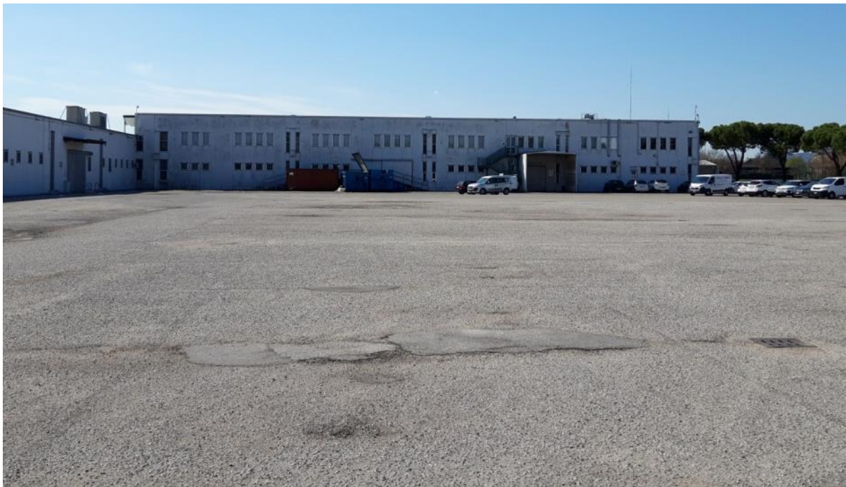
Foto 3: piazzale retrostante con prospetto uffici sullo sfondo
