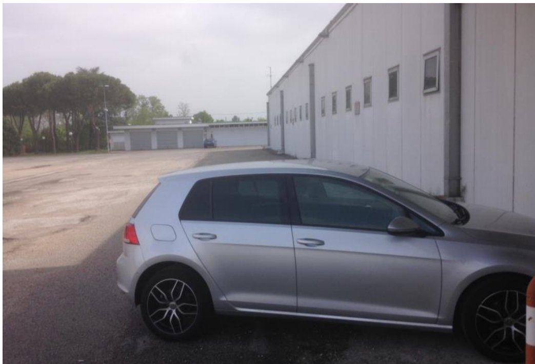
Foto 2: scorcio della facciata nord-ovest
