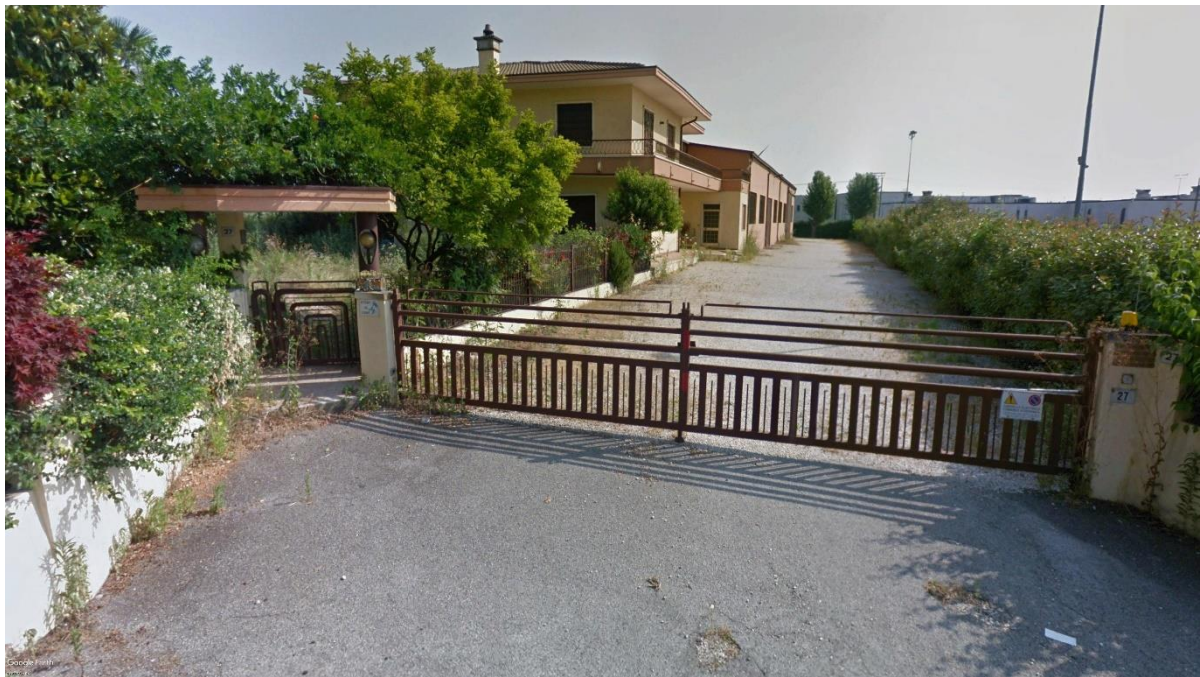
Figura 22: edificio Dalla Barba
