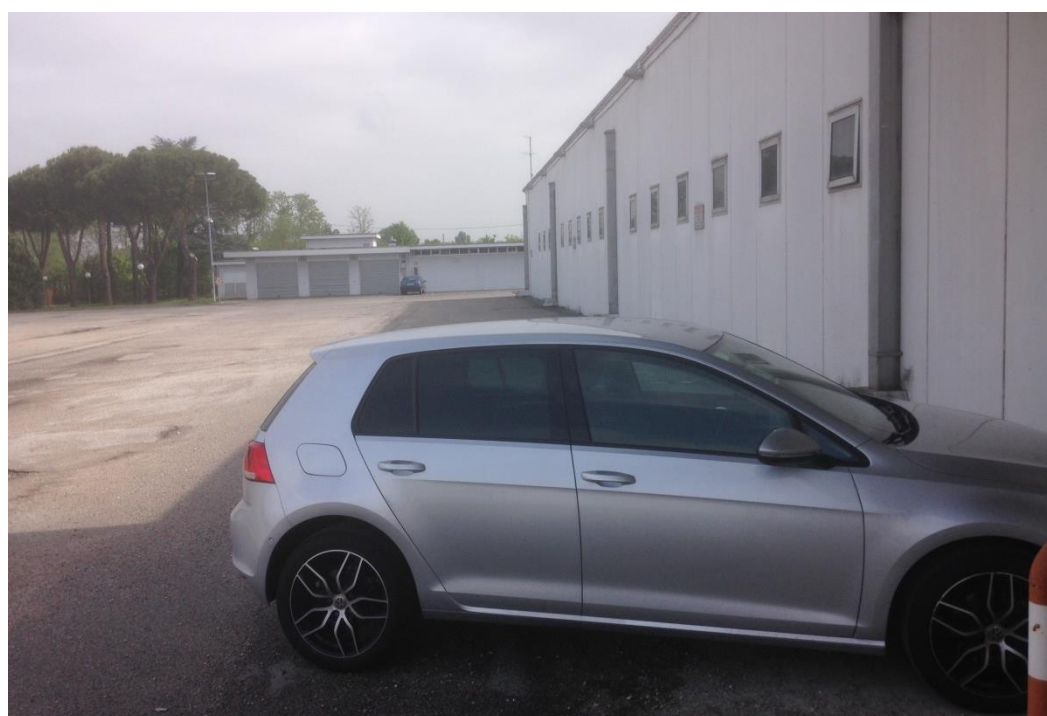
Figura 11: scorcio della facciata nord-ovest
