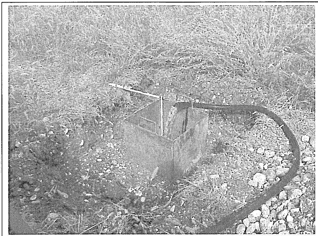
Prova di permeabilità su pozzetto (PO1)
