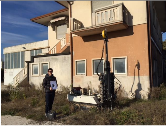
Vista del punto di esecuzione della prova penetrometrica dinamica DIN1
