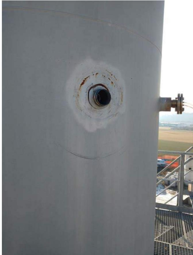
Figura 4: Fotografia delle operazioni di campionamento: camino CM1 dell'impianto SICIT 200 S.p.A.
