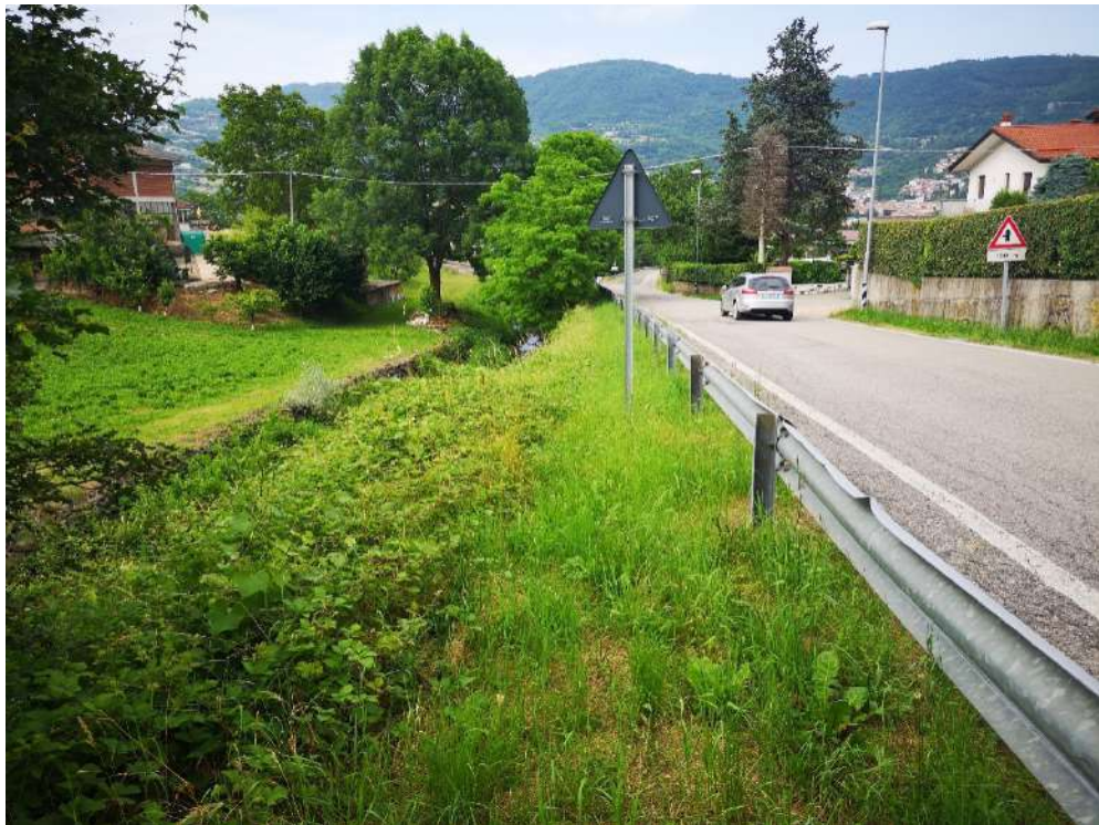
Foto della valle Preona a valle ponte via Gonzati; si nota il notevole dislivello tra la strada e l'alveo della valle;
