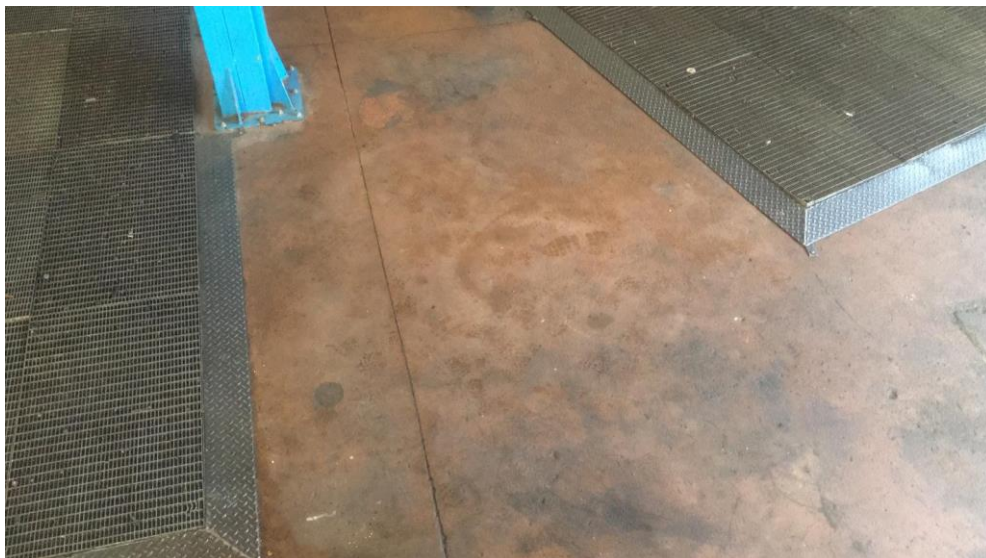
Figura 1. Pavimentazione area messa in sicurezza
