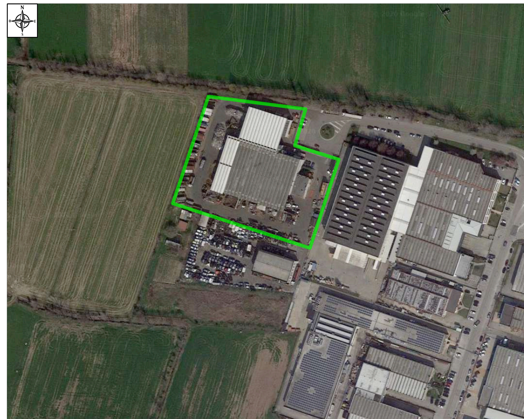
: Impianto di recupero Marostica Giuseppe Rottami S.p.A.
