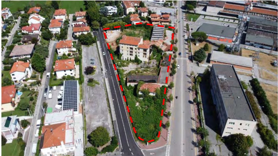
Fig.2: Visione aerea dell'area
