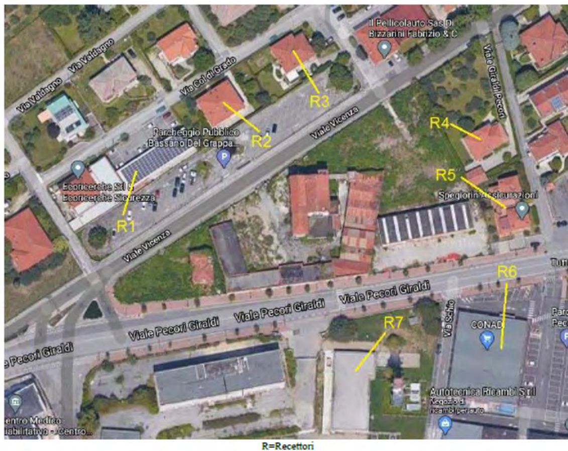
Fig.22: Fotografia aerea con individuati i ricettori e l'area di cantiere con gli edifici da abbattere
