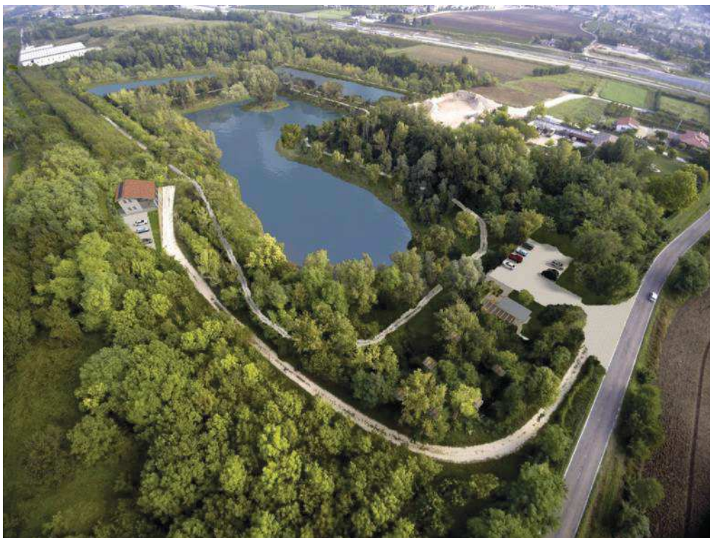
Figura 67 – Rander fotografico dei lagheti in seguito alla realizzazione degli interventi. Vista in direzione nord
