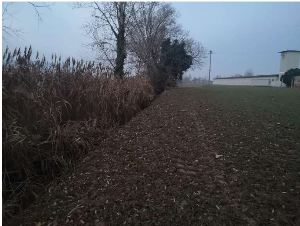
Foto del fosso su cui verrà scaricato il bacino ad ovest dove si è misurato il livello del pelo d'acqua a -2,0 m dal p.c.;
