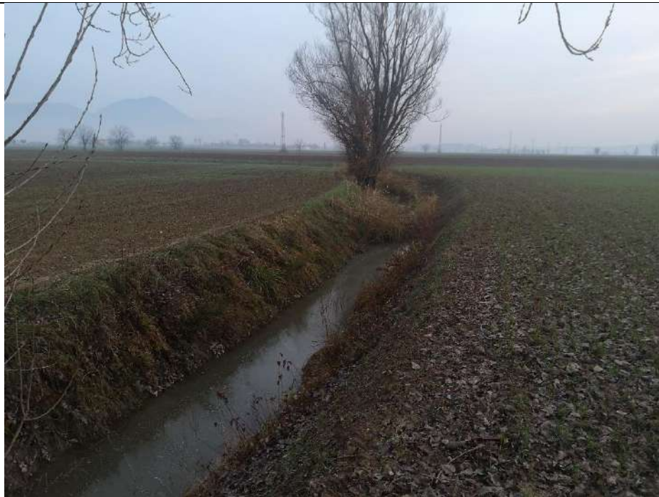
Foto dello scolo demaniale Pedrina nel lato ovest;
