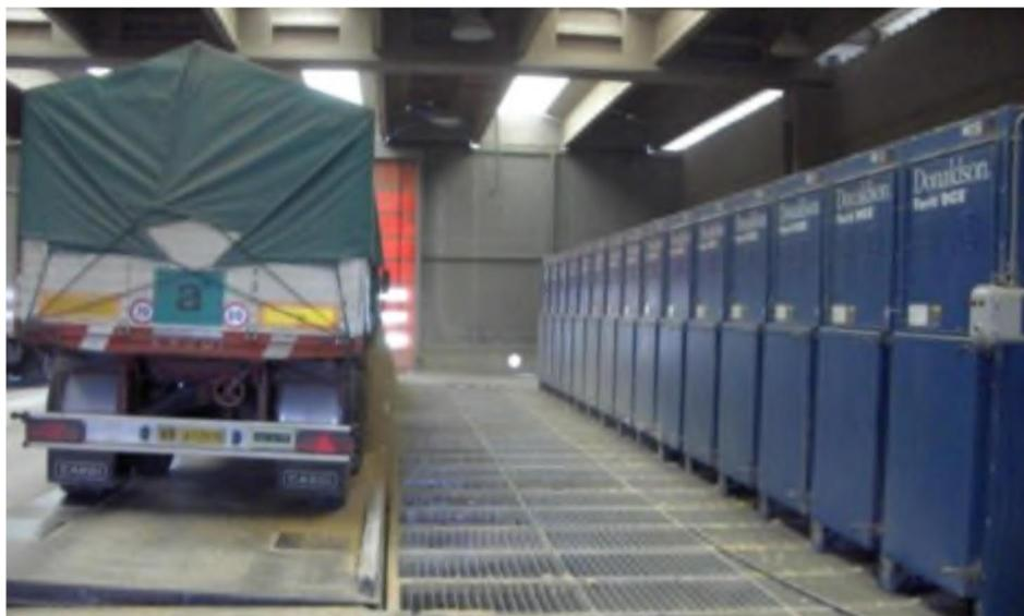
Figura 8: immagine esemplificativa impianti di aspirazione e trattamento su fossa di scarico
