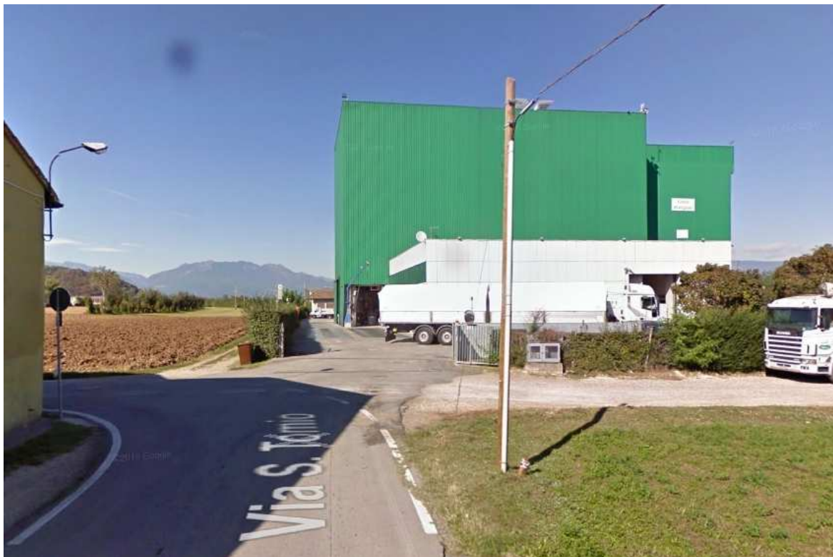
Figura 5. Vista Via S.Tomio ingresso stabilimento
