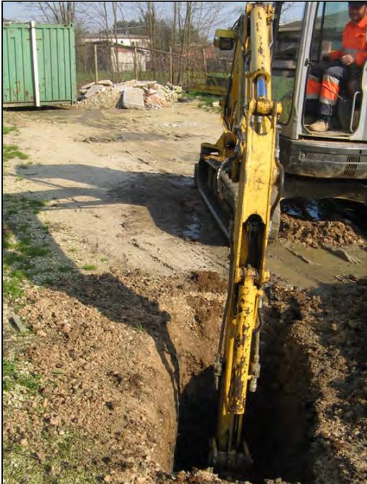
*Esecuzione trincea mediante escavatore*
