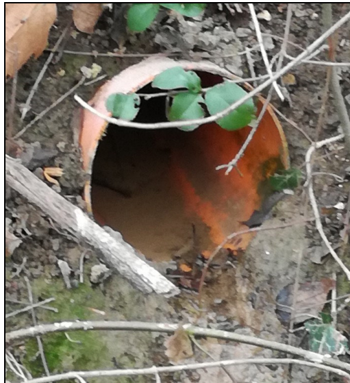
Foto 5 – condotta di scarico esistente (PVC De 160 mm)
