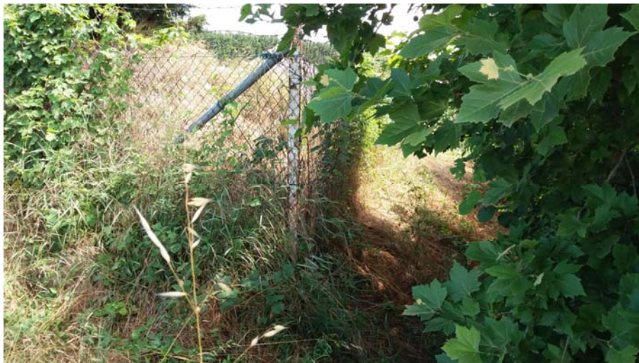
Recinzione e piantumazioni
