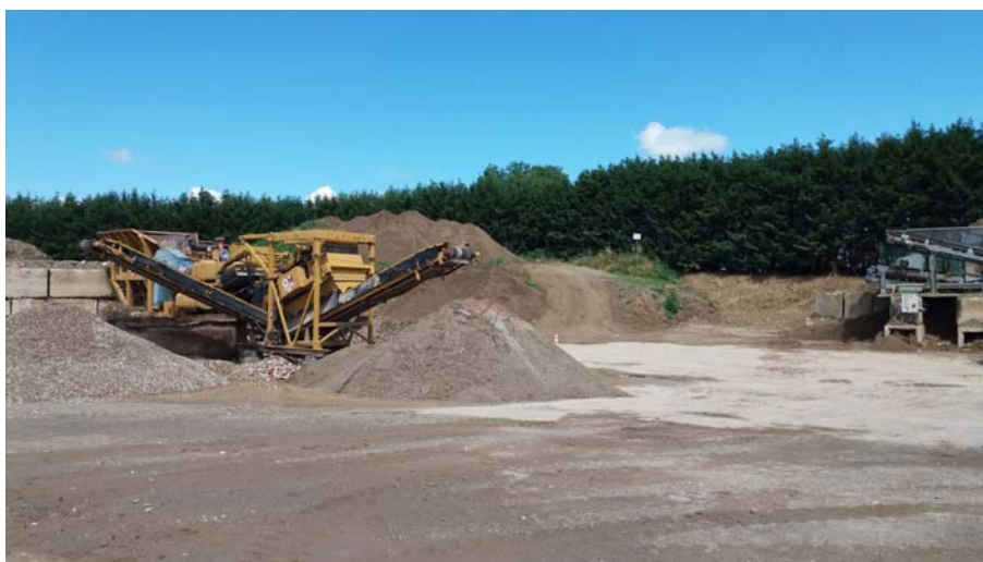
Vista dal piazzale in cui si svolgono le lavorazioni
