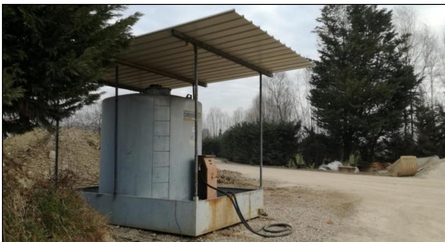
Foto 4 – impianto di erogazione carburante
