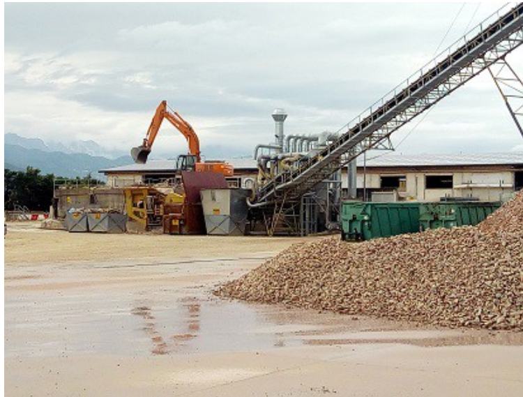
Impianto di frantumazione e soffiatore
