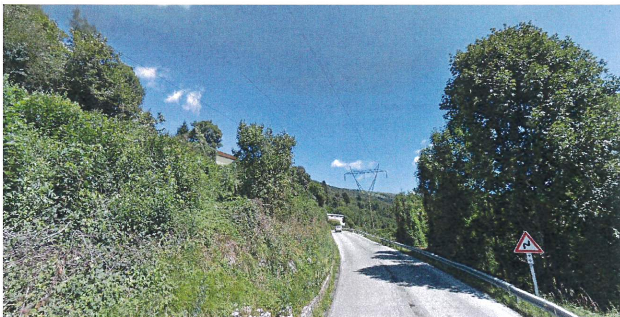
VISTA DALLA PROVINCIALE 94 IN ARRIVO DA SUD
