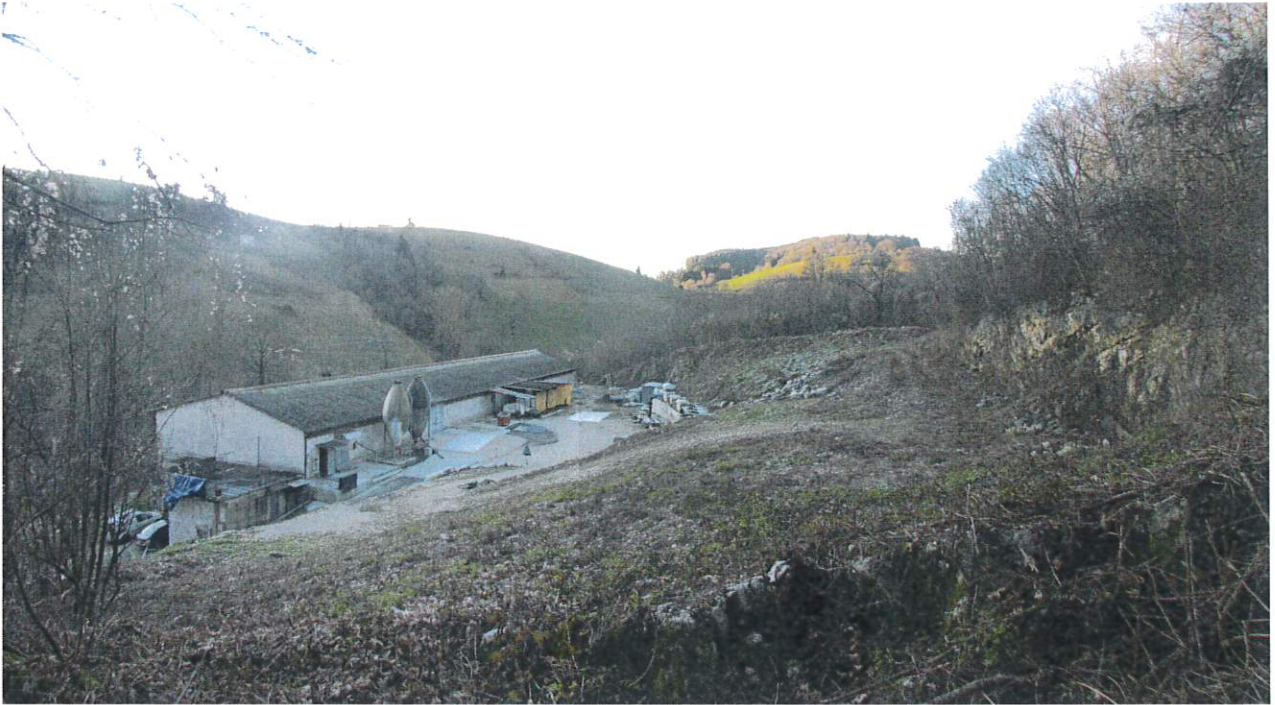
VISTA 2 DA NORD
