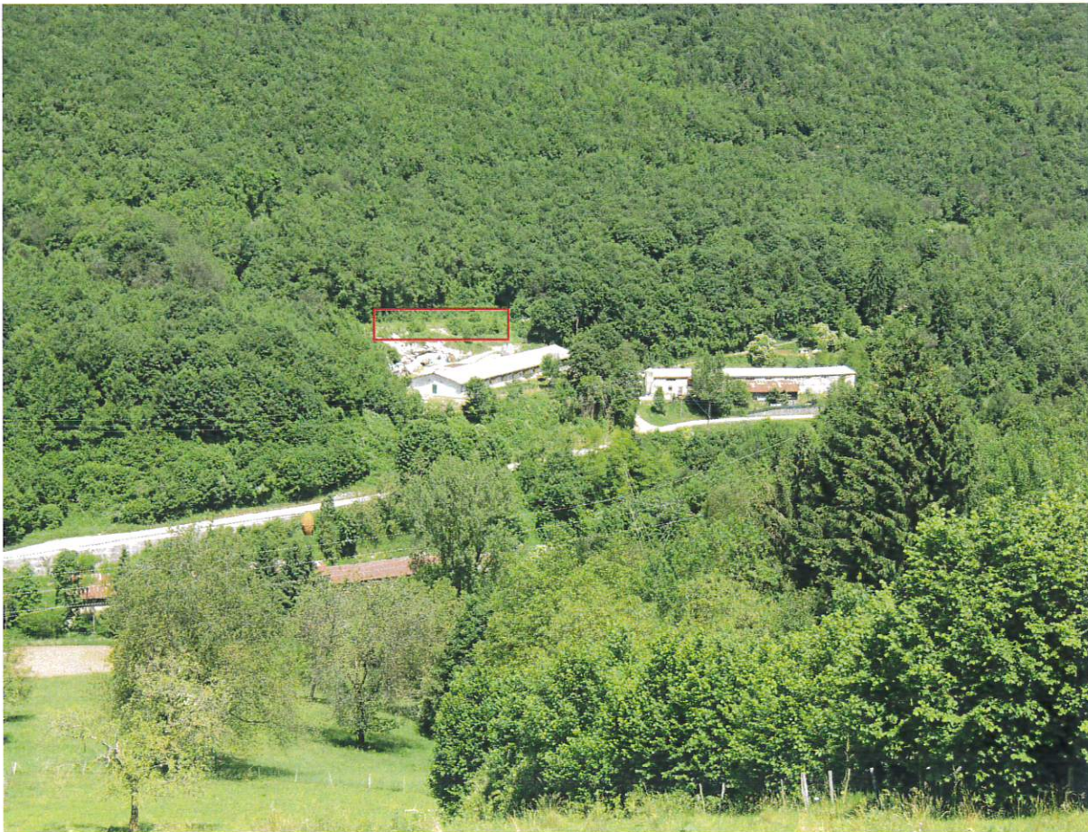
VISTA DAL VERSANTE OPPOSTO, MONTE LINTA
