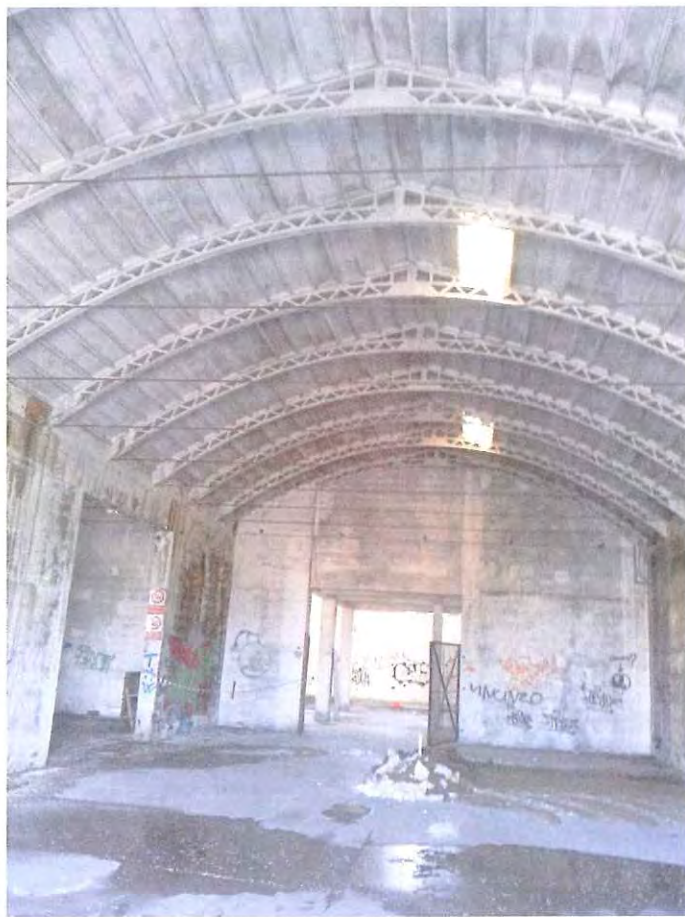
Interno della copertura in cotto di vari edifici
