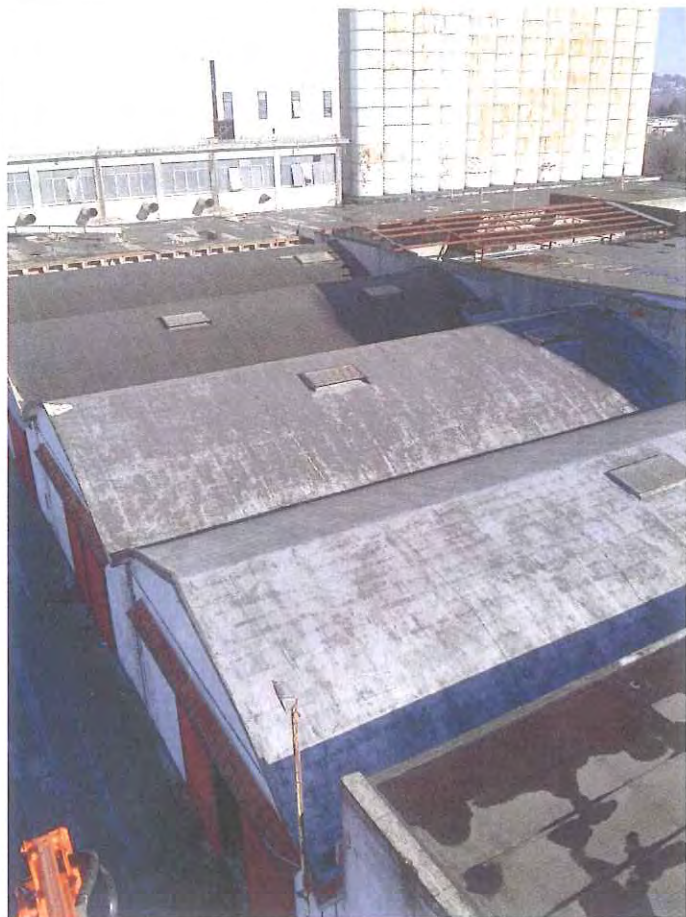
Copertura guaina vari edifici
