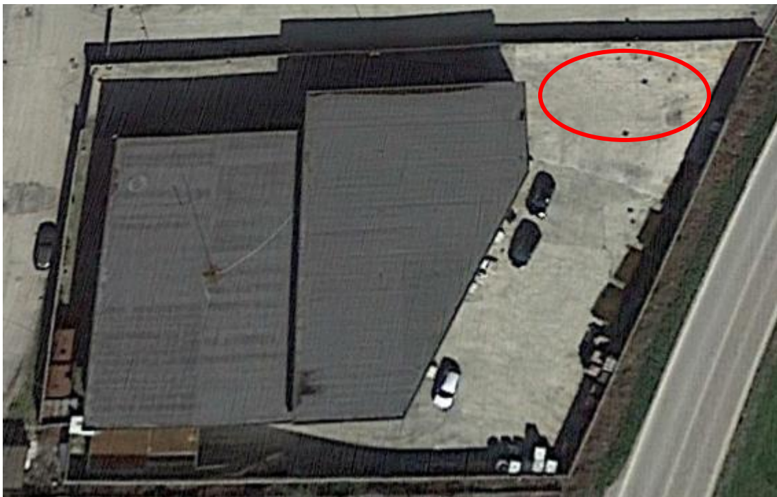
Figura 2. Localizzazione pavimentazione maggiormente danneggiata
