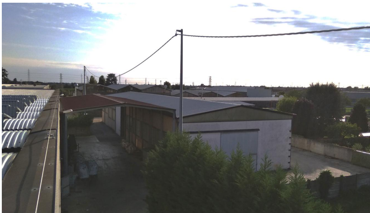
FOTOGRAFIA 2 – COPERTURA CAPANNONE PRINCIPALE
