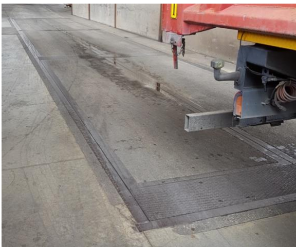
Figura 18 – Fotografie delle pese installate.
