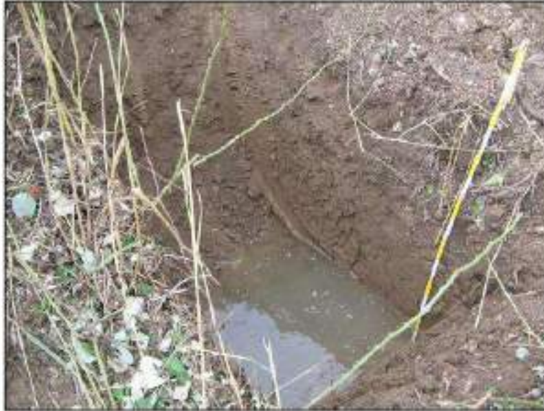
Foto 1 – Scavo eseguito in data 03.09.2014 mediante escavatore meccanico (terreno limo argilloso sabbioso con falda freatica riscontrata a circa 1 m al p.c.).
