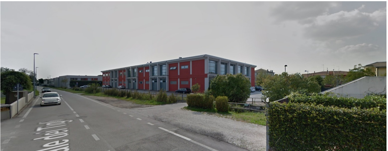
Vista nord-est del fabbricato esistente da Viale dei Tigli
