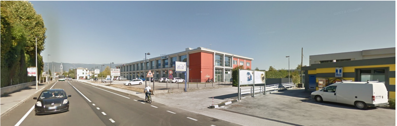
Vista sud-ovest del fabbricato esistente da Via Mazzini
