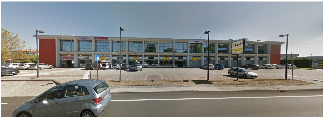
Vista ovest del fabbricato esistente da Via Mazzini SS47 – ampliamento della superficie di vendita al piano terra
