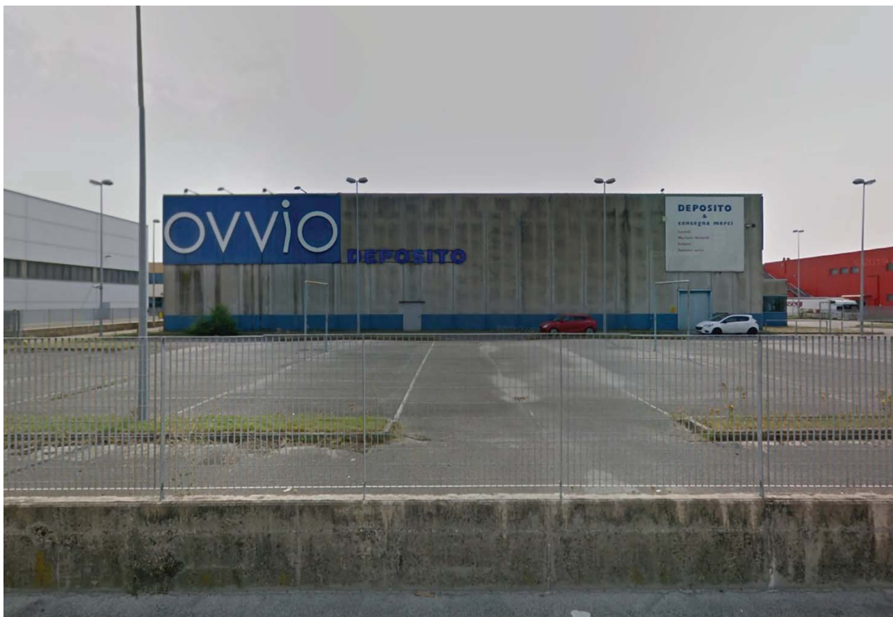
vista attuale dell'immobile dalla strada
