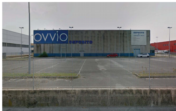
vista attuale dell'immobile dalla strada
