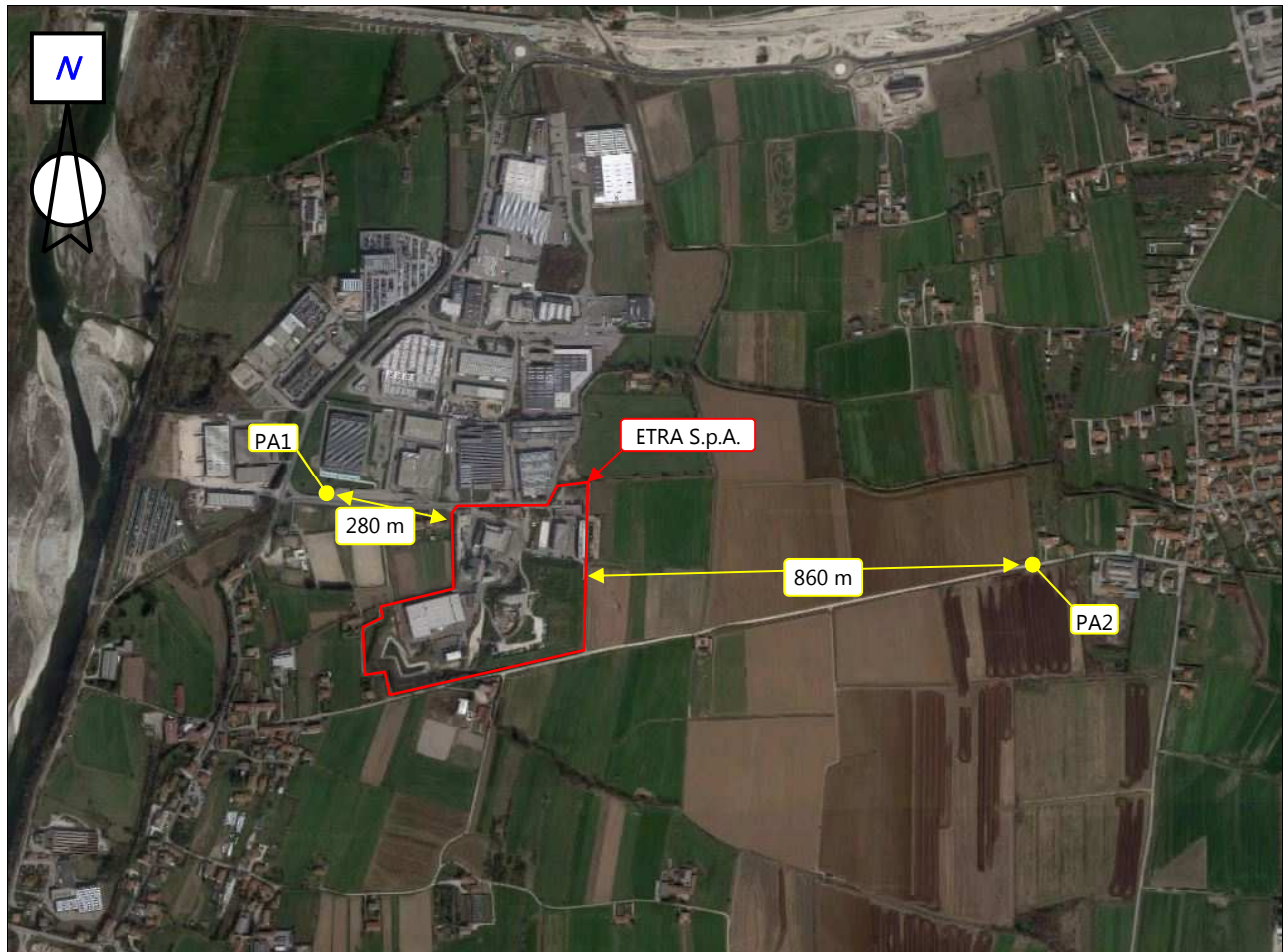
Figura 11.4. Posizione dei punti analoghi rispetto all'impianto
