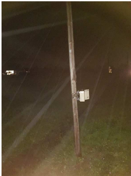
Collocazione del dispositivo contatraffico
