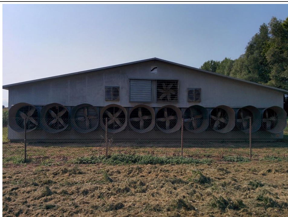
Foto 2 – Gli estrattori sulla testata del ricovero
