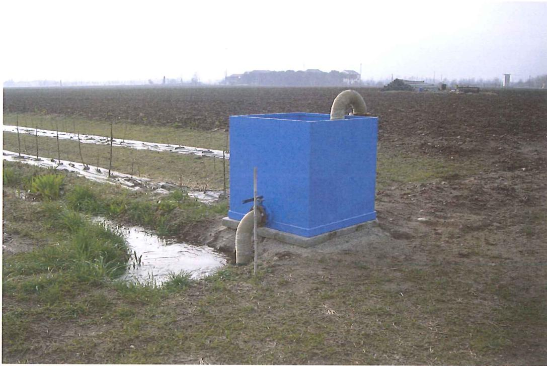
FOTO 5: Particolare zona immissione e misura portata per ricarica della falda
