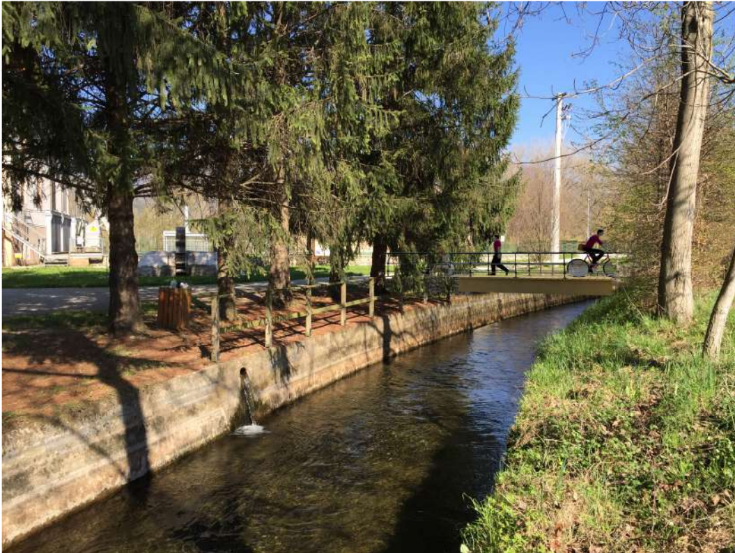
Vista canale Post Operam
