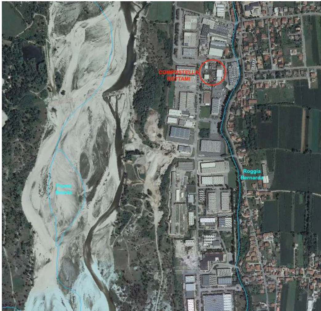
Figura 13: Reticolo idrografico dell'area circostante l'impianto di recupero di Compostella Rottami srl [fonte: Geoportale Nazionale, 2019]
