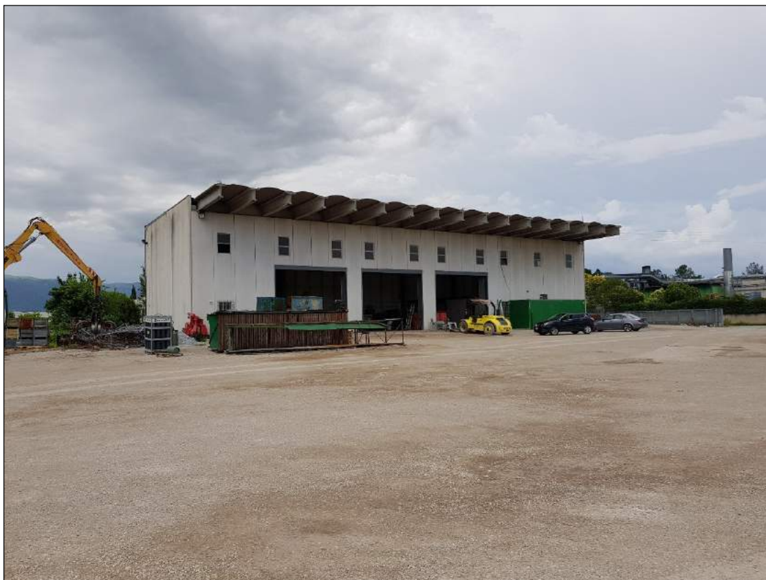
FOTO 1 (Vista sud interna al lotto di proprietà)
