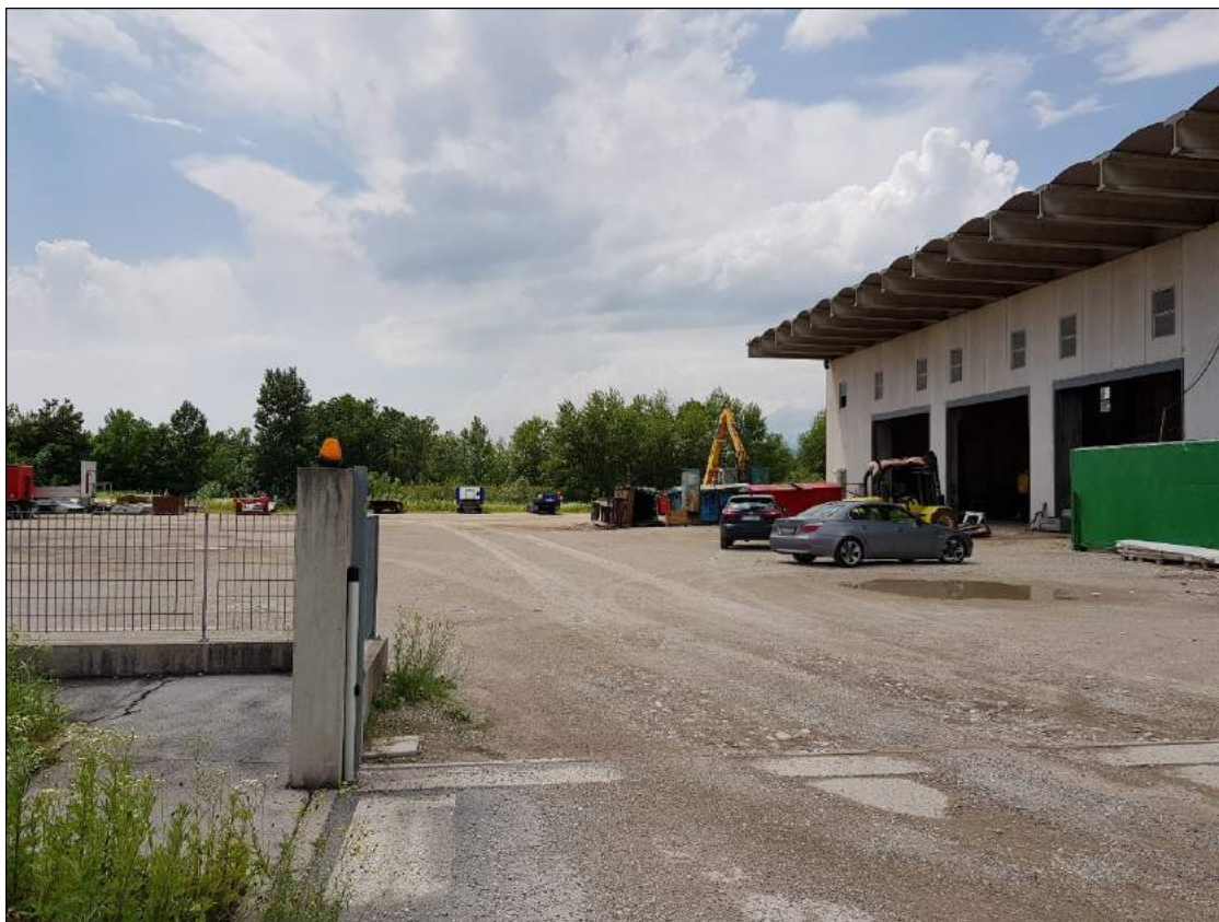
FOTO 2 (Vista est interna al lotto di proprietà)
