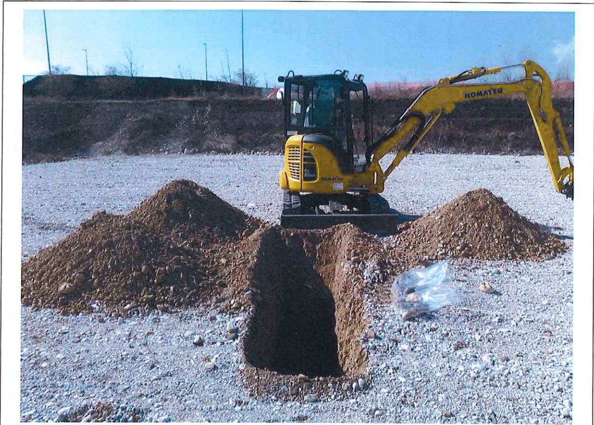
Panoramica dell'esecuzione dello scavo SC11
