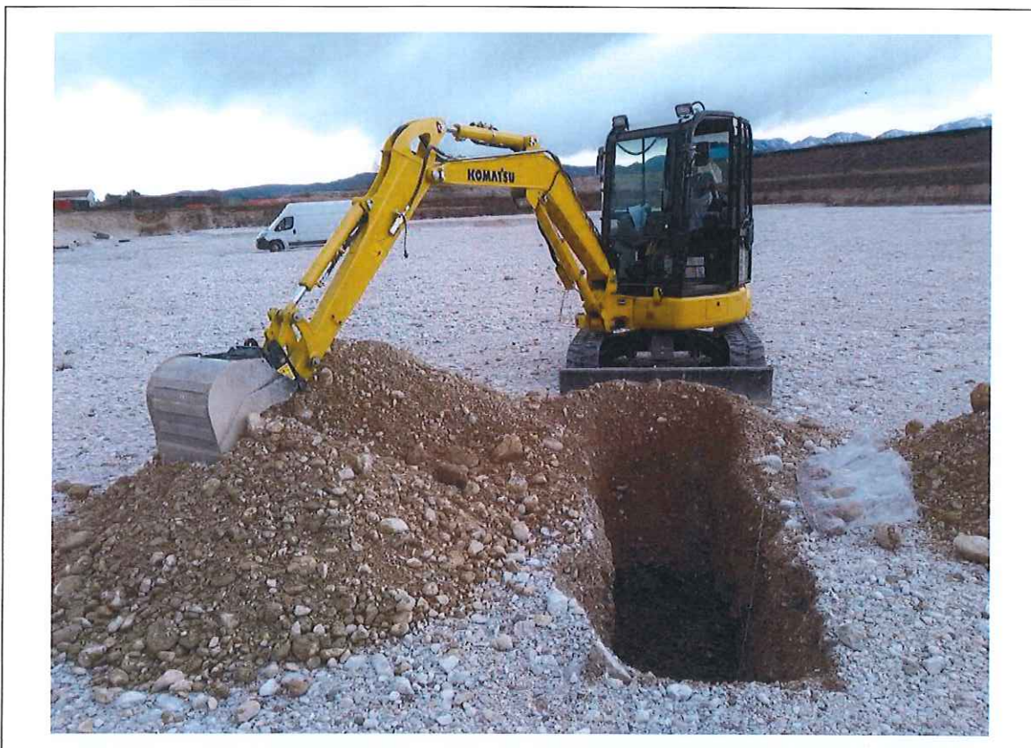
Panoramica dell'esecuzione dello scavo SC5
