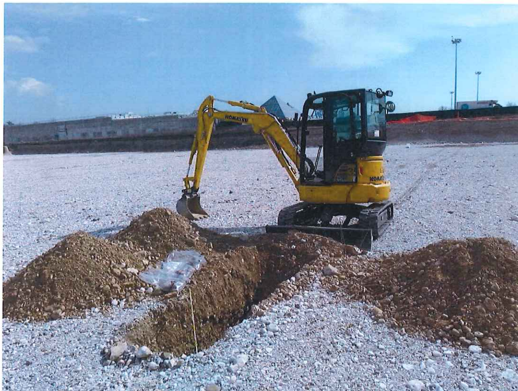
Panoramica dell'esecuzione dello scavo SC10
