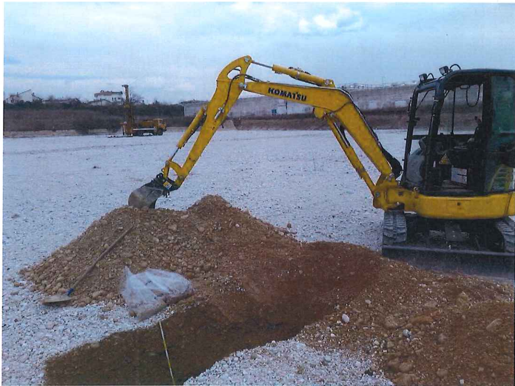
Panoramica dell'esecuzione dello scavo SC8
