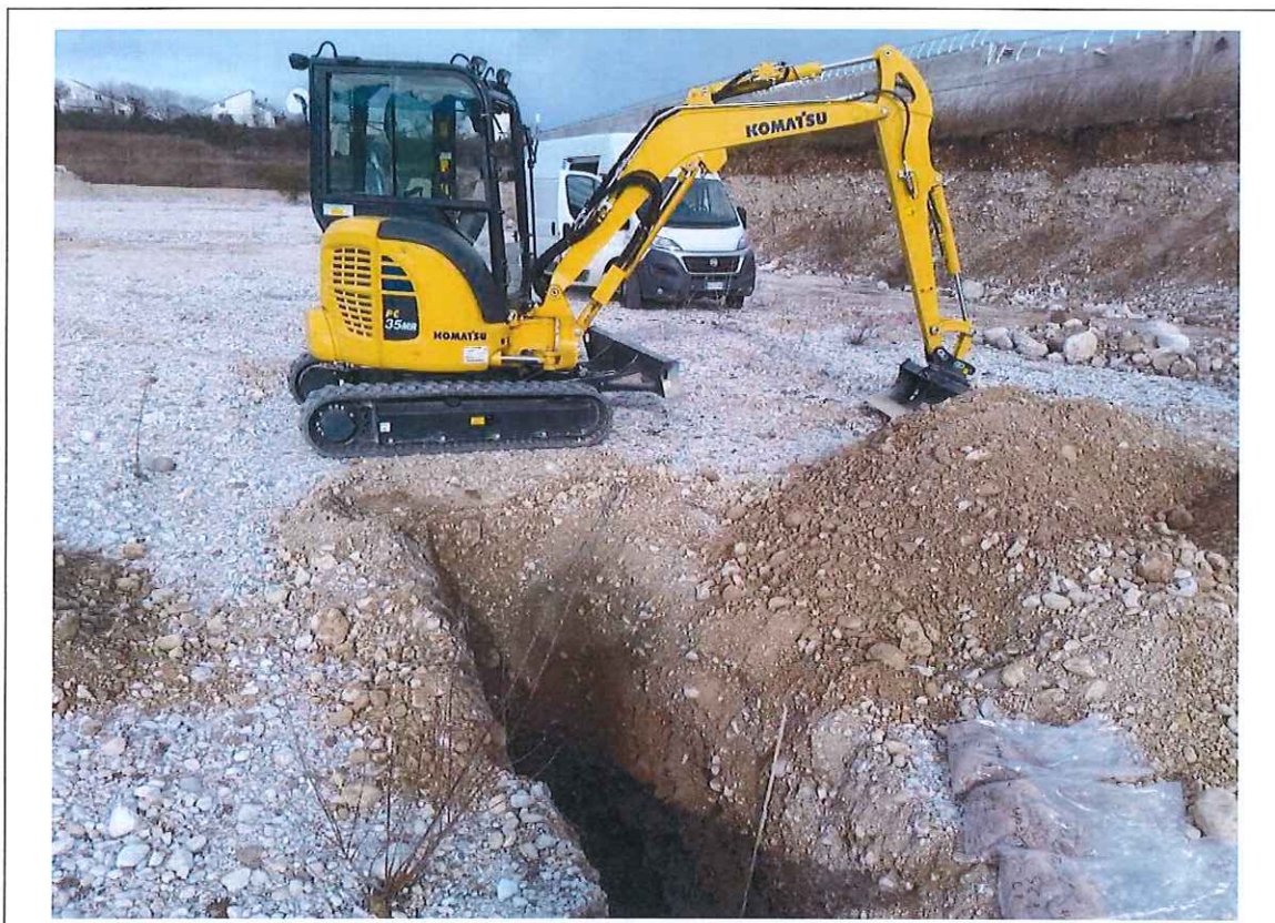
Panoramica dell'esecuzione dello scavo SC9
