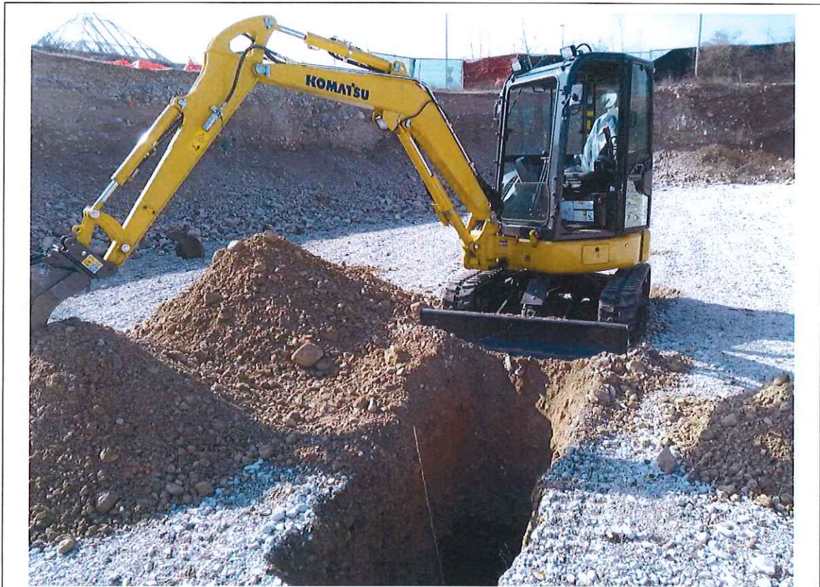
Panoramica dell'esecuzione dello scavo SC12
