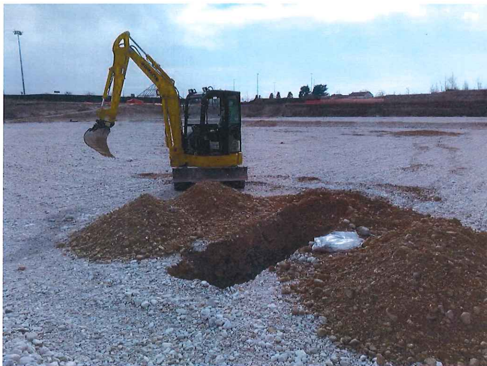
Panoramica dell'esecuzione dello scavo SC6
