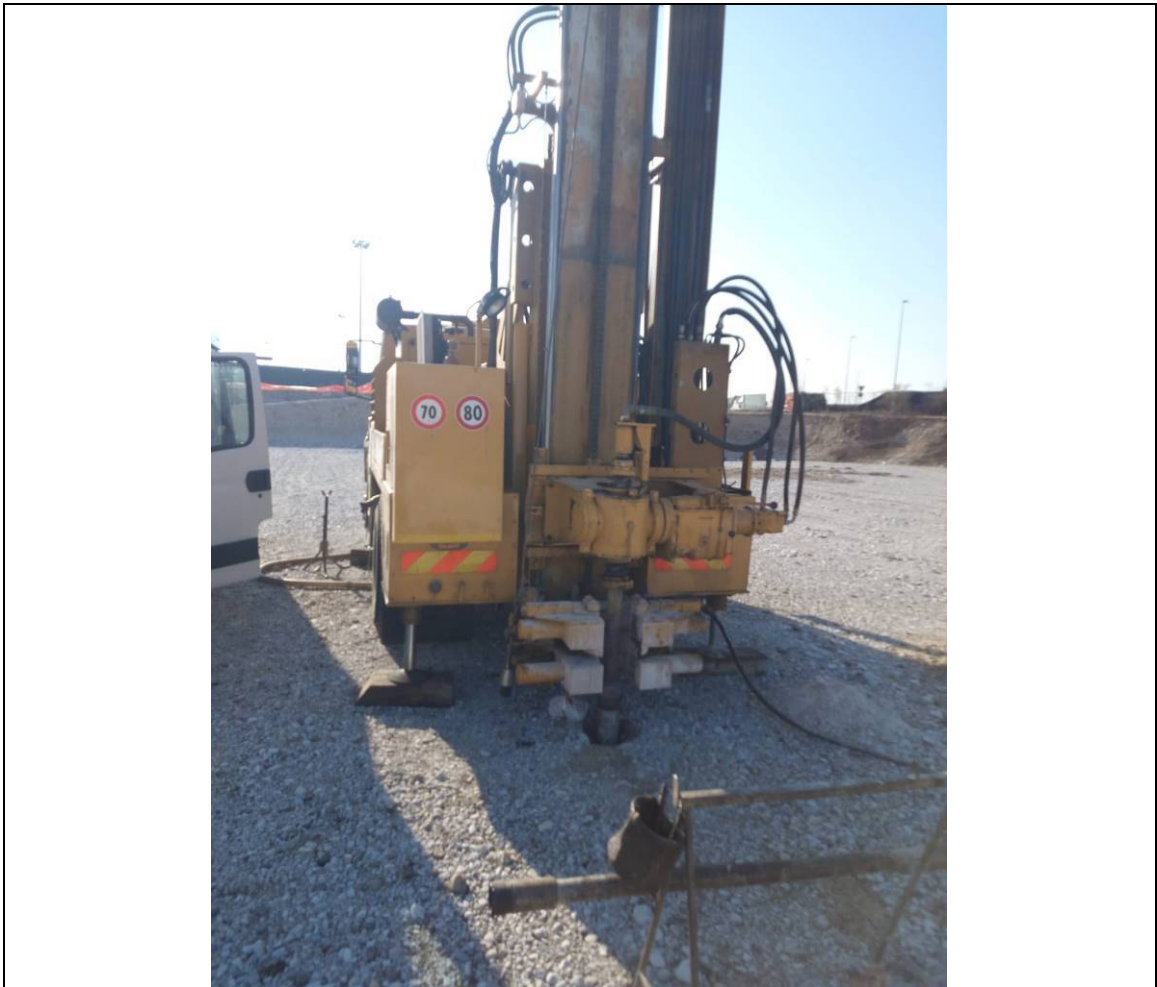
Panoramica dell'esecuzione del sondaggio a carotaggio continuo S3
