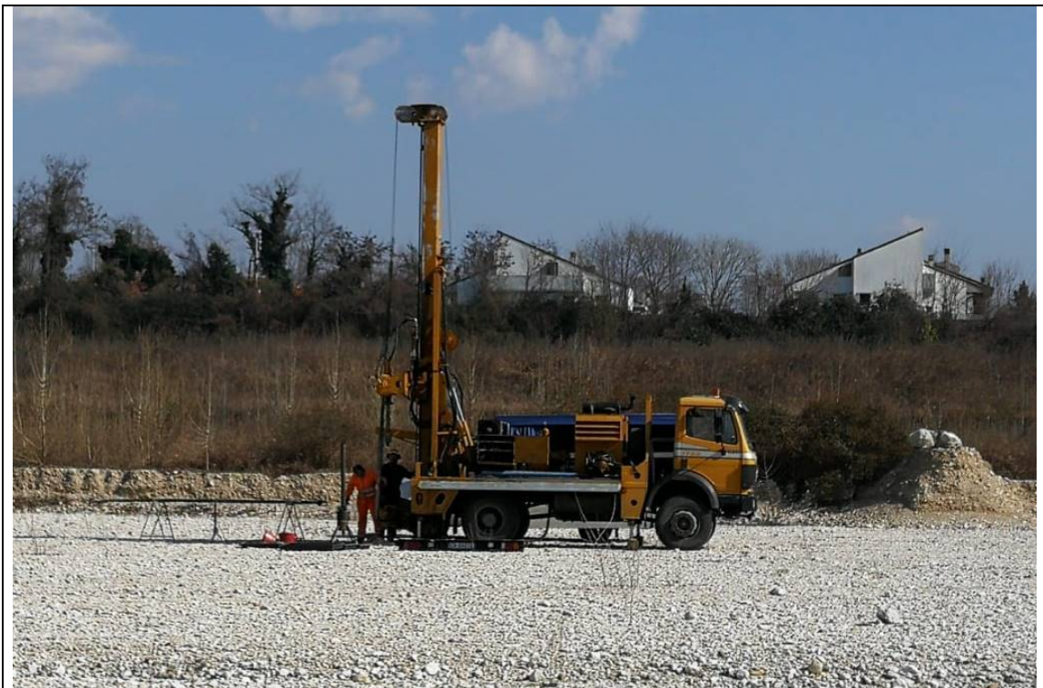
Panoramica dell'esecuzione del sondaggio a carotaggio continuo S1
