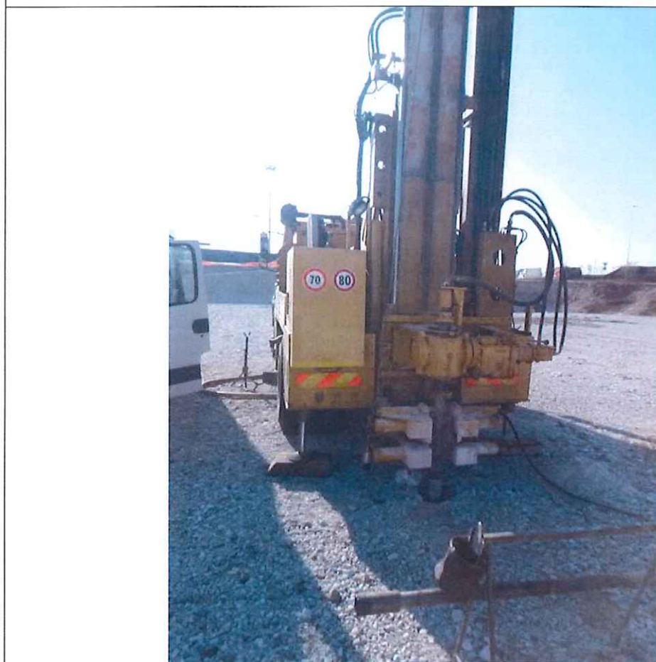
Panoramica dell'esecuzione del sondaggio a carotaggio continuo S3 (amb)
