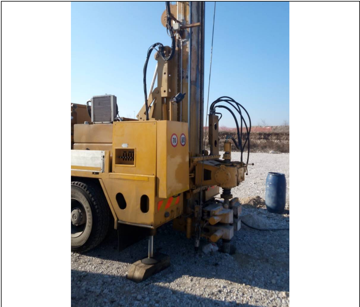
Panoramica dell'esecuzione del sondaggio a carotaggio continuo S2
