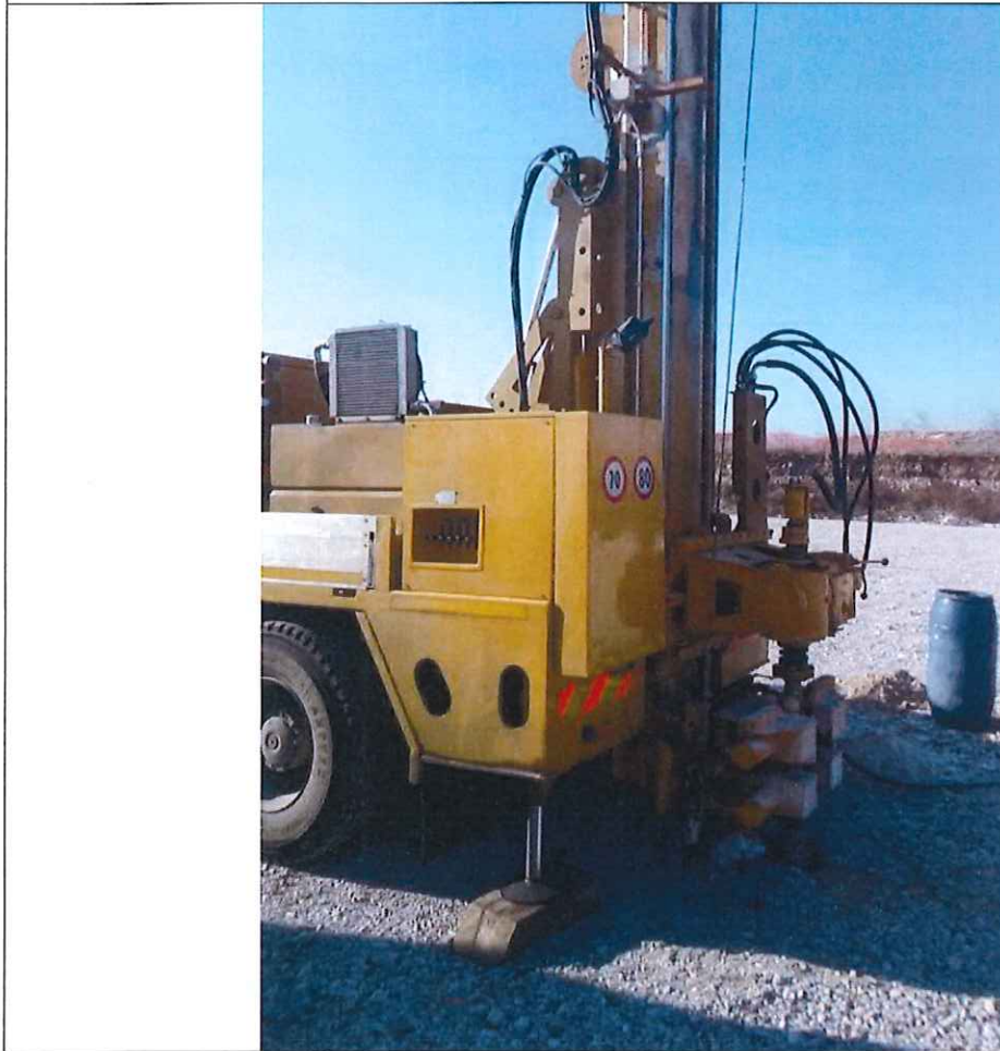
Panoramica dell'esecuzione del sondaggio a carotaggio continuo S2 (geo - amb)
