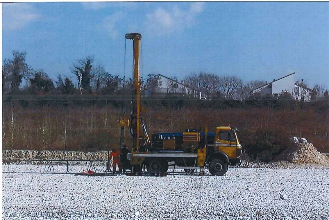
Panoramica dell'esecuzione del sondaggio a carotaggio continuo S1 (amb)
