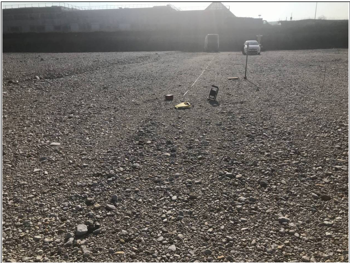
Esecuzione di indagine di sismica attiva (MASW)
