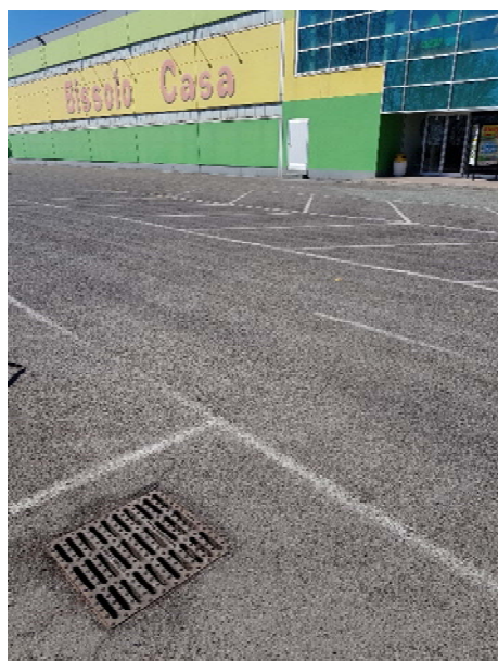
Figura 3: Punto di scarico della copertura dell'edificio commerciale posto a sud.
