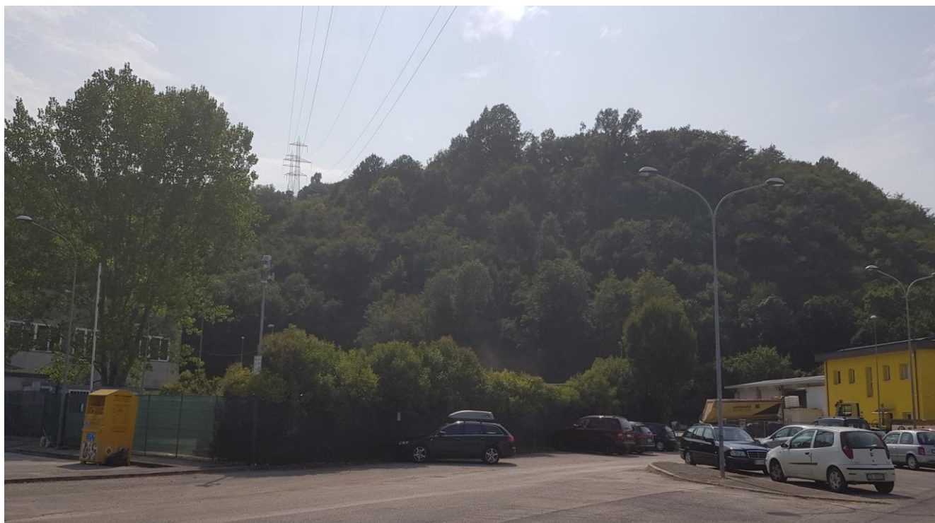
Fig. 1 – passaggio dei cavi sul deposito materiali della proprietà del sig. Pellattiero Antonio
