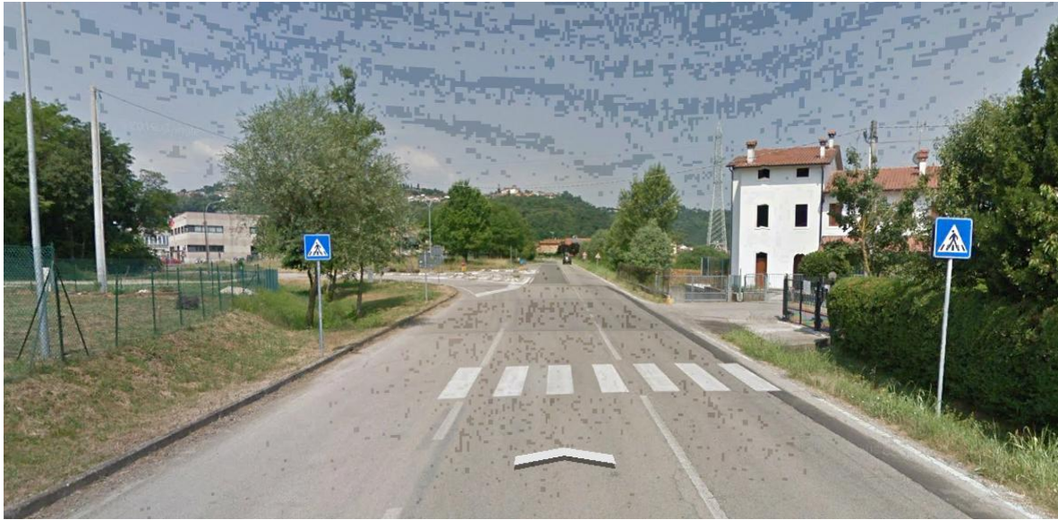
Vista ovest - via Biron (SP 36) con intersezione su via Canestrello
