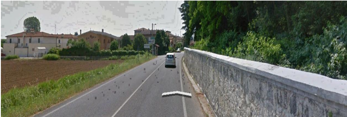
Vista sud - via Biron (SP 36)
