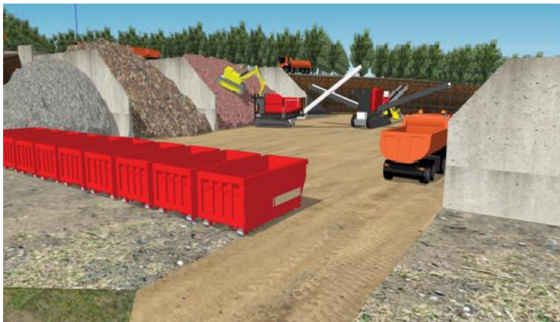
Fig.6.7: Dettaglio delle lavorazioni
