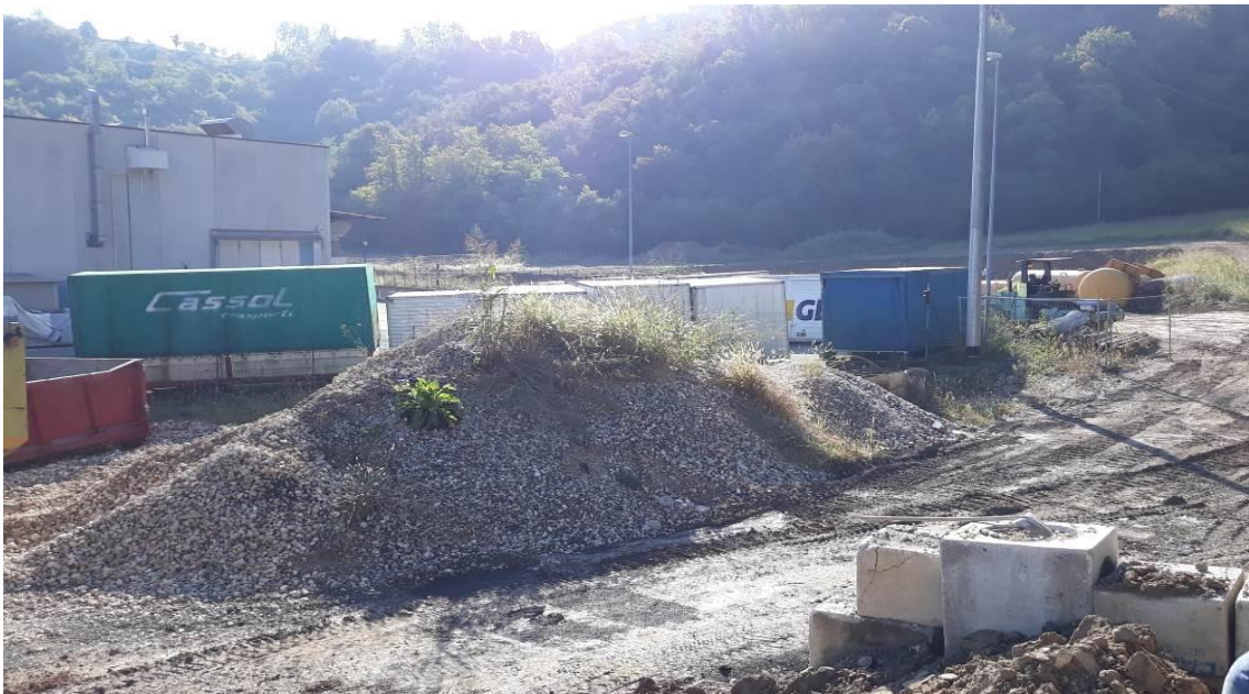
Fig. 5.10: Zona di accesso all'area di intervento
