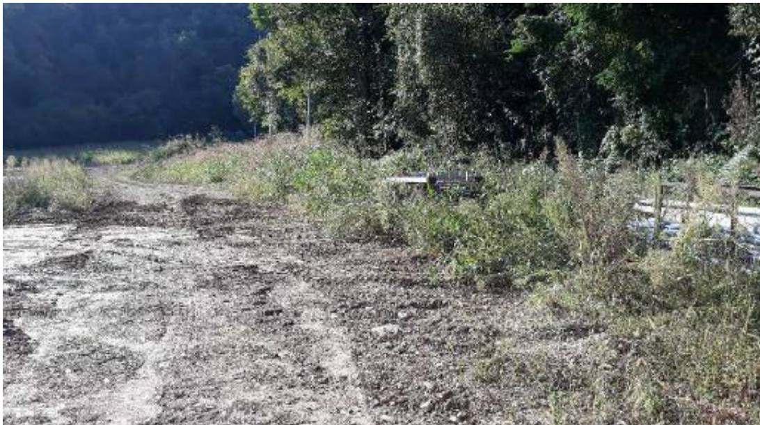
Fig. 5.6: Foto area di intervento direzione sud dove verrà realizzata la strada di accesso all'impianto.
