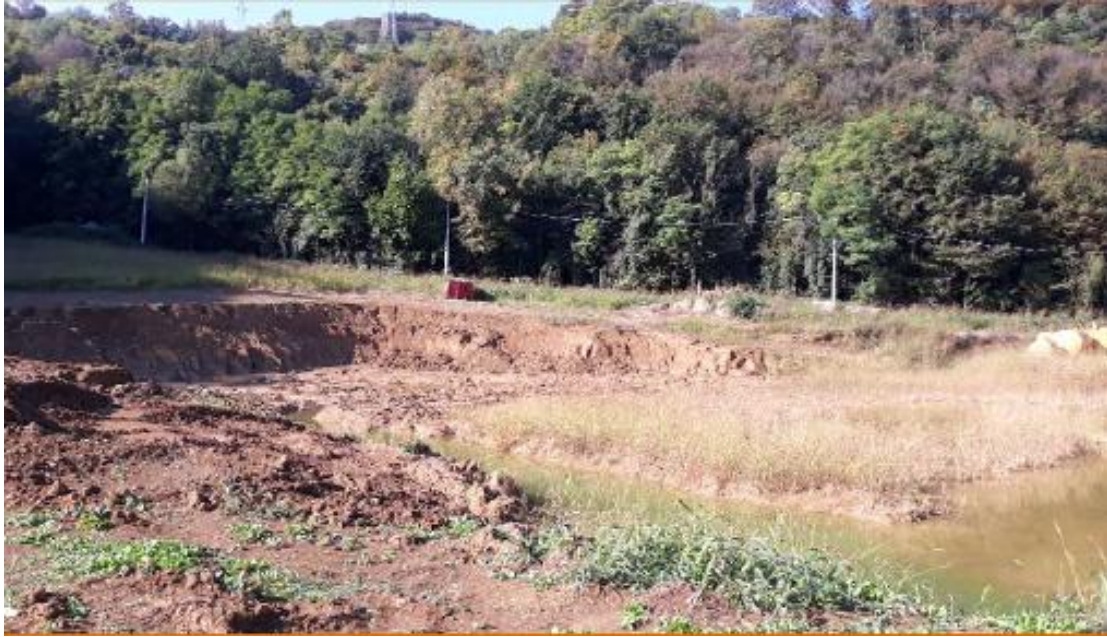
Fig. 5.1: Foto area di intervento direzione sud-ovest
