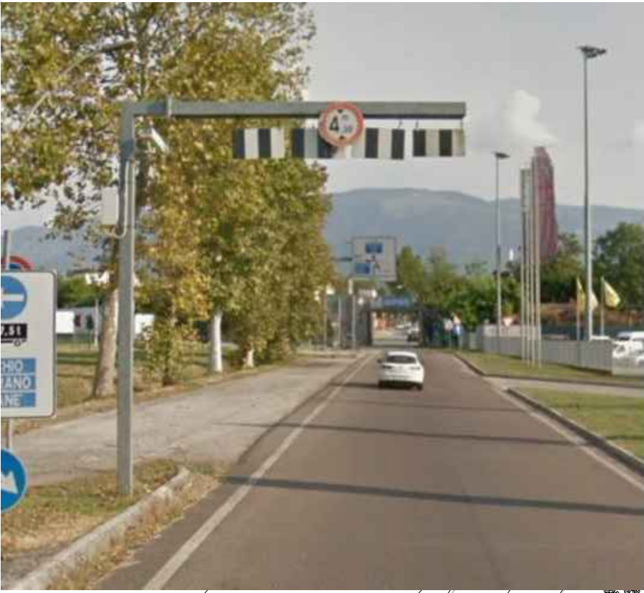
PORTALE DA RIPOSIZIONARE
