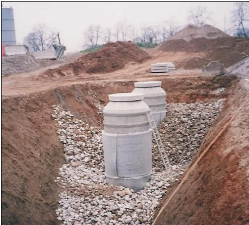
Figura 4. Realizzazione di pozzi di infiltrazione.
