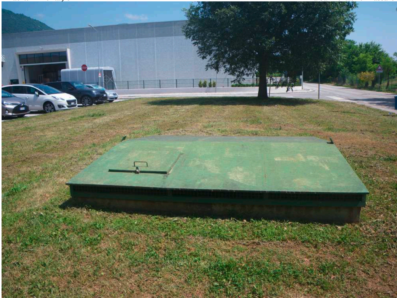
Foto N.1 : Ubicazione del Pozzo P1 di approvvigionamento idrico autonomo dello stabilimento in uso a SE
