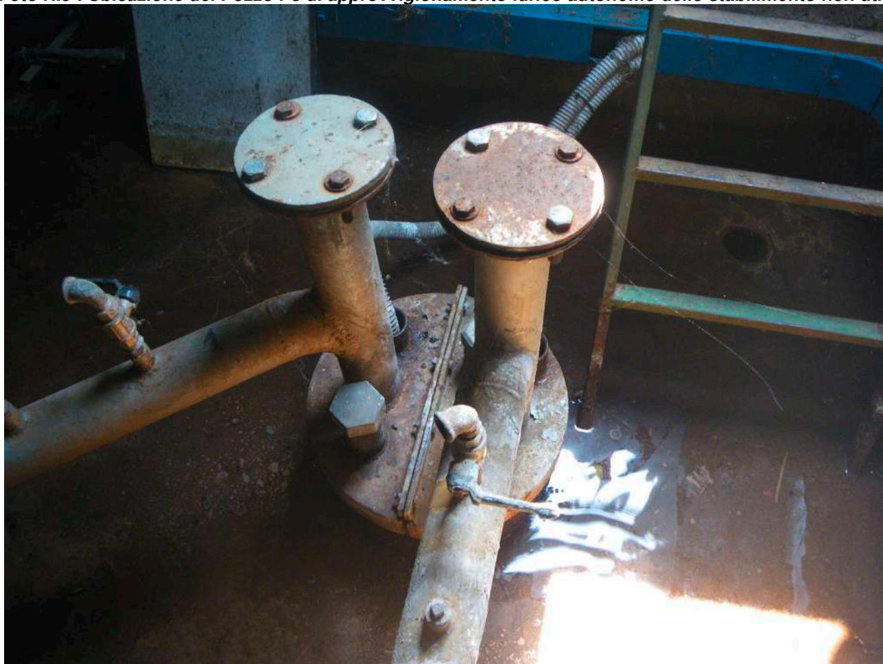
Foto N.6 : Testa del Pozzo P3 di approvvigionamento idrico autonomo da 300mm non utilizzato attualmente Rilievo fotografico : 26 Giugno 2019
