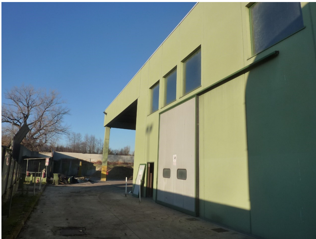
Figura 17: Vista della struttura esistente e, in fondo, l'area in cui verrà realizzata la tettoia
