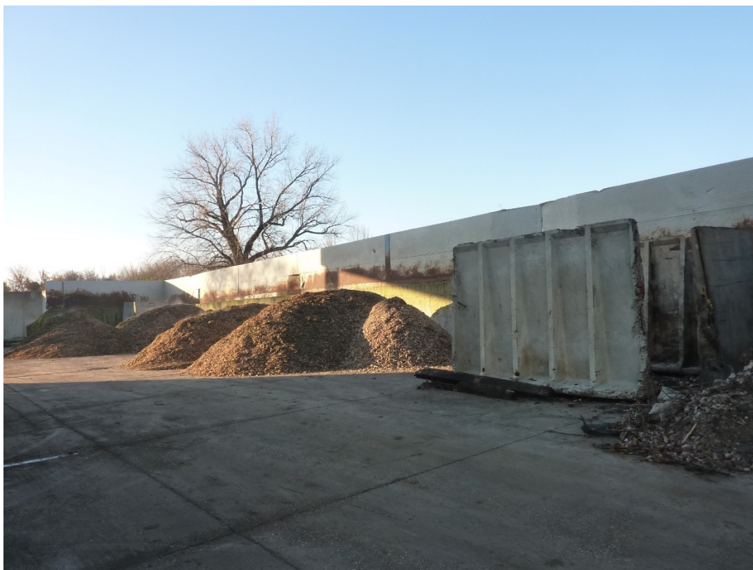
Figura 14: Vista dell'area dove verrà collocata la tettoia
