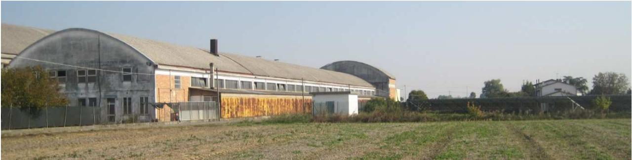
Foto lato sud-ovest – in evidenza la copertura in eternit. Si evidenzia inoltre l'ampliamento fino al confine di proprietà della struttura originale.
