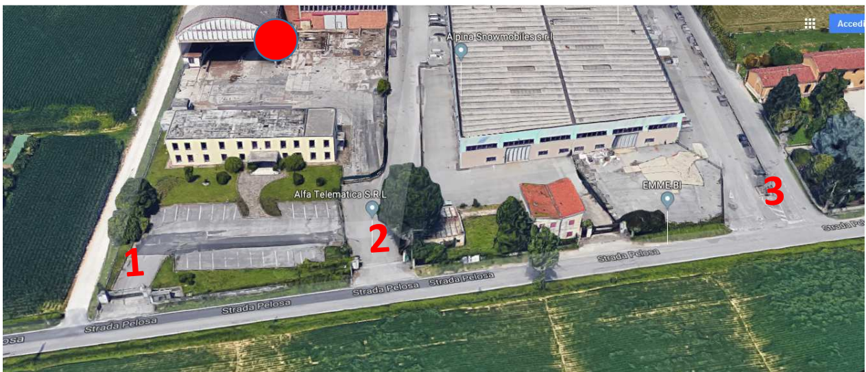
Vista aerea accessi all'area da Strada Pelosa (bollino rosso: sito oggetto di intervento).
