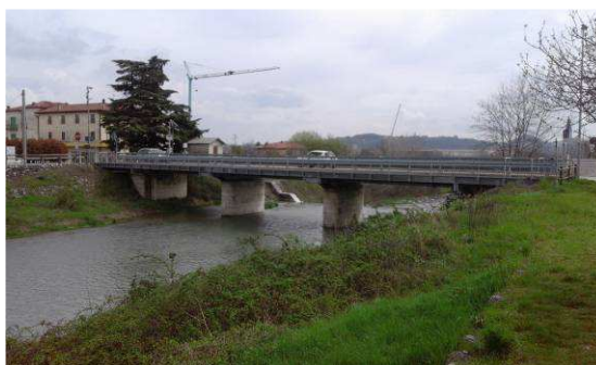
Foto n.15 : Infrastruttura stradale SP39
