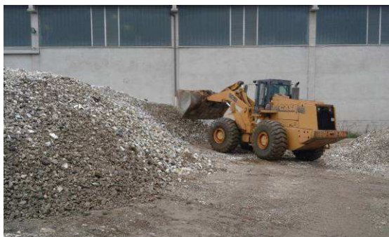
Foto n.6 : automezzo in fase di lavoro
