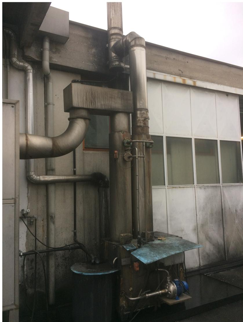
Foto 3. Sistema di abbattimento del pirolizzatore/combustore nella posizione attuale
