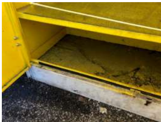
Particolare della vasca interna di raccolta a tenuta stagna sul fondo dell'armadio per liquidi infiammabili che stocca le taniche del carburante per go-kart.
