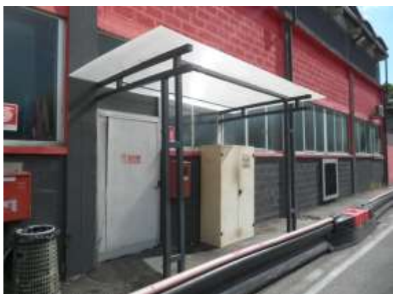
Box di deposito carburante (benzina senza piombo).
