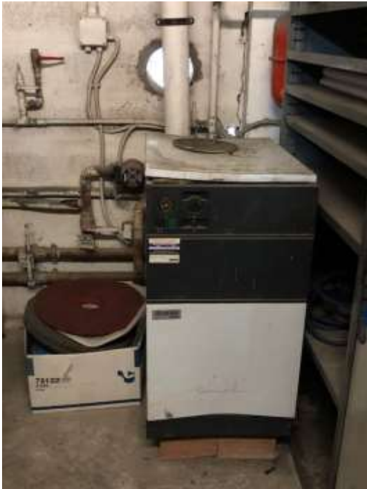
La caldaia dismessa.
