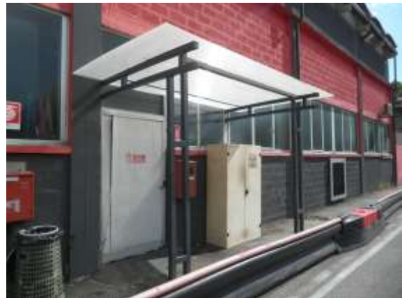
Box di deposito carburante (benzina senza piombo).
