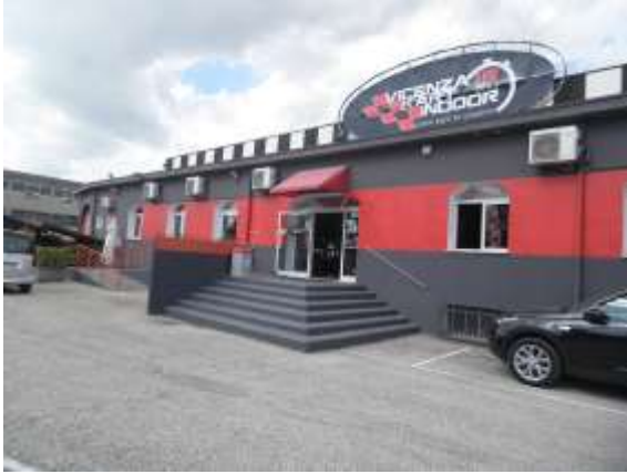
Area ingresso e parcheggio.
